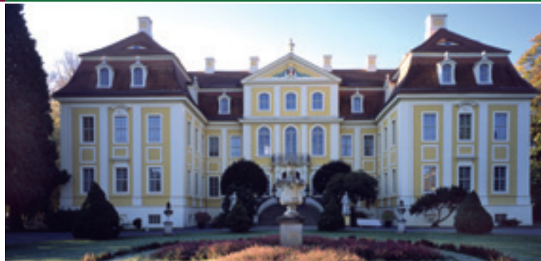
Čelní pohled na hrad
